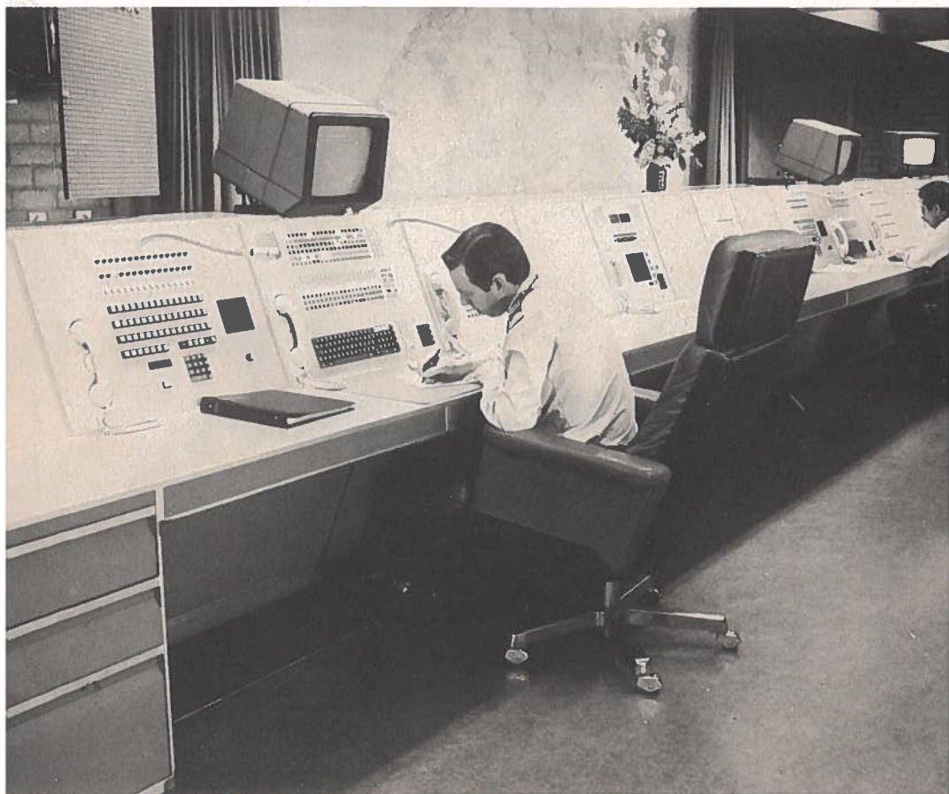
Uitgebreide bedieningstafel met concentratieschakeling (Brandweer Rotterdam)
